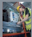
Drift av anläggning
